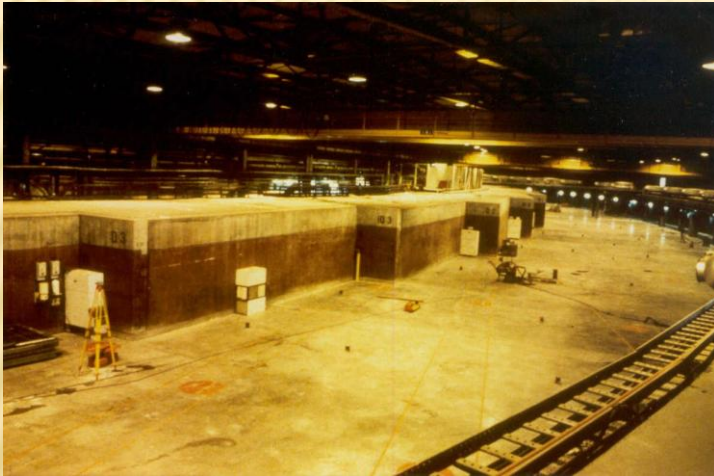
Le hall non équipé
